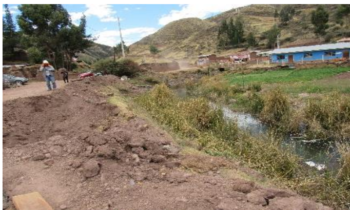
FOTO 03: Sección hidráulica estrangulada de ancho variable, anexo Chacamayo.
