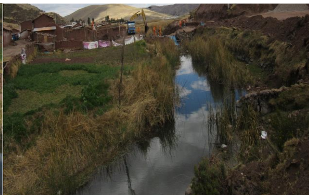
FOTO 02: Cauce colmatado con material de sólidos arcilla lodo y Totoral, riberas de talud natural.
